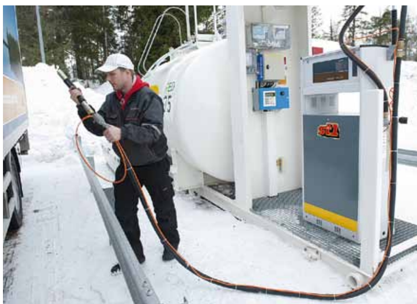
Valion jakeluauton kuljettaja Raine Vartiainen esittelee uutta tipatonta tankkausjärjestelmää. Etanolidieseliä ei pääse valumaan luontoon. Oranssi kaapeli menee polttoainetankin anturiin.
